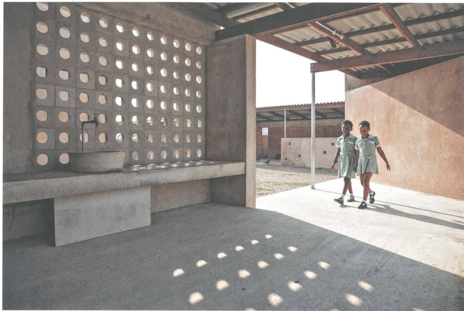
Das Gebäude für die Kinder der 3. Jahrgangsstufe besteht außer dem Klassen- und dem Lehrerzimmer aus Freibereichen für unterschiedliche Aktivitäten. Für die Gartenmauern wurden Lochsteine, sogenannte breeze blocks entwickelt, die das richtige Verhältnis von Luftzirkulation und Windschutz, Lichteinfall und Durchblicken ermöglichen. (Architektur/Bau: Hochschule München, 2014)
