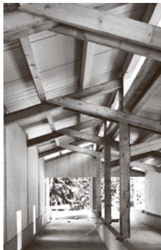
Rohbau eines Hühnerstalls – Konstruktion und Lichtführung bestimmen den Innenraum.
