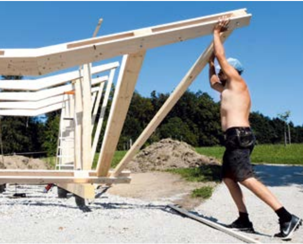
Gemeinsames Aufrichten der Holzkonstruktion.
