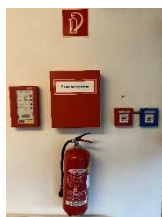
Kennzeichnung Feuerwehrbedienfeld/Feuerwehrpläne
